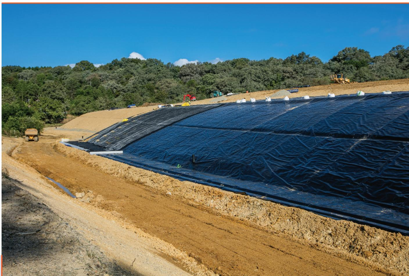
Chantier du centre de stockage de Bittola à Urrugne (64) mettant en œuvre **TenCate Geolon® Robulon PET** : géotextile hautement résistant conçu pour prévenir l'érosion et maintenir la terre végétale.
